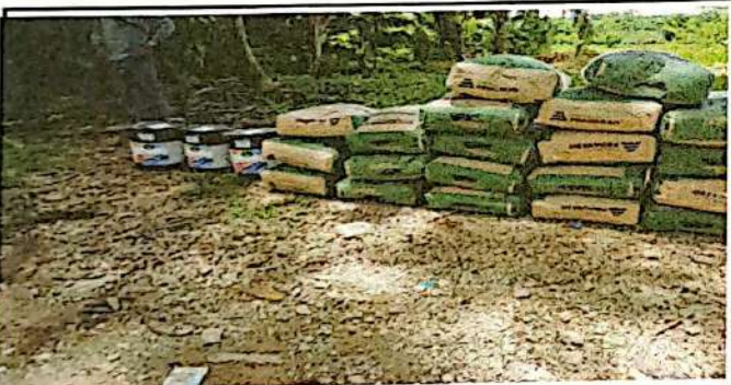
Foto 3: compra de cemento y pintura.
