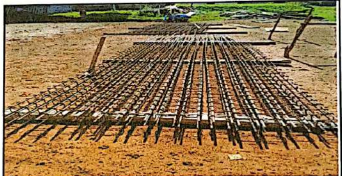
Foto 4: Nivelacion de terreno, armadura de columnas y trazo de medidas
