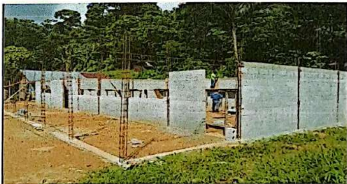
Foto 6: Colocacion de bloks, fundicion de soleras y fundicion de columnas.
